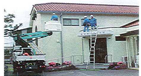
中川公民館にWi-Fiの工事が行われ、念願のインターネット環境が整いました。
